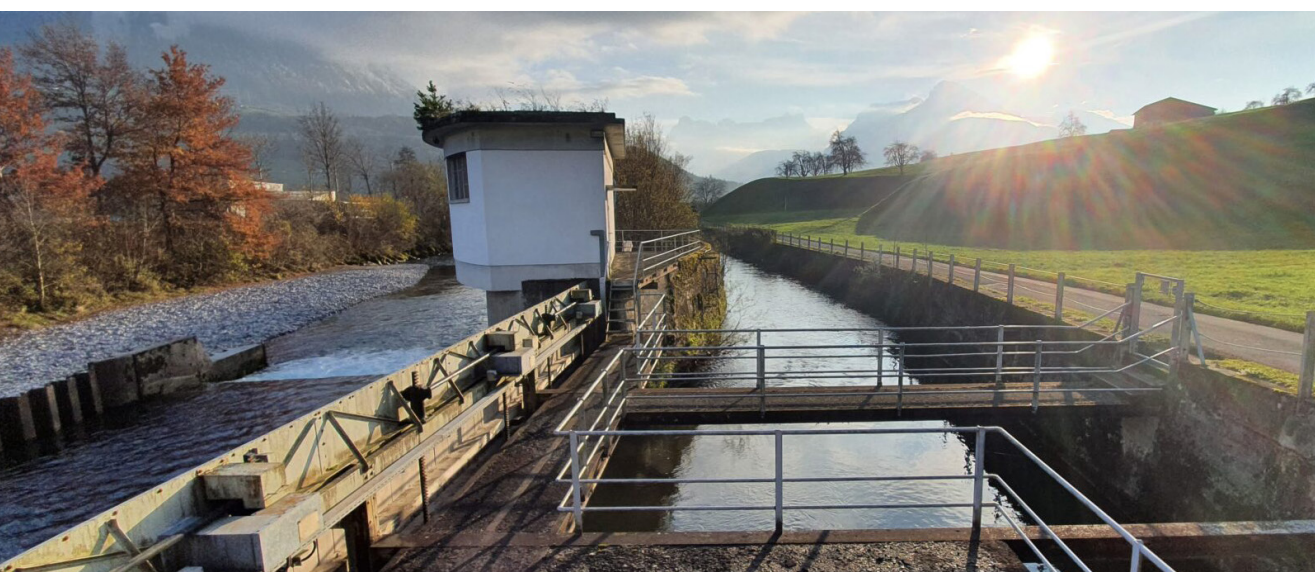
Zurück zur Natur: das stillgelegte Kraftwerk in Brunnen wird zurückgebaut und die Muota revitalisiert.
