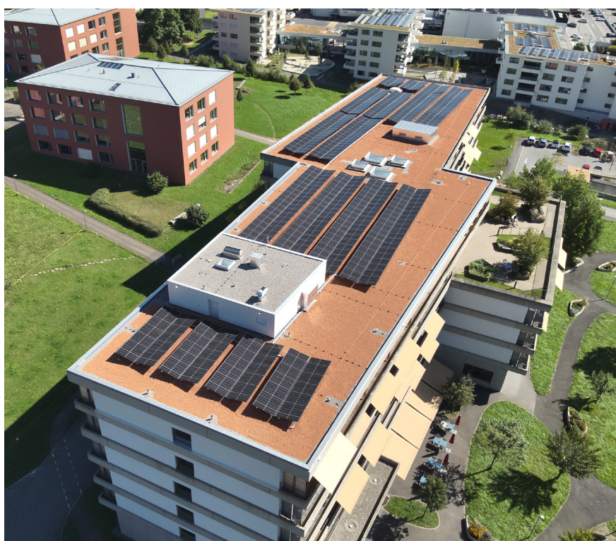
Nummer 8: Mit dem Bau der Photovoltaikanlage auf dem Alterszentrum Rubiswil hat ebs nun acht eigene Photovoltaikanlagen in Betrieb.
