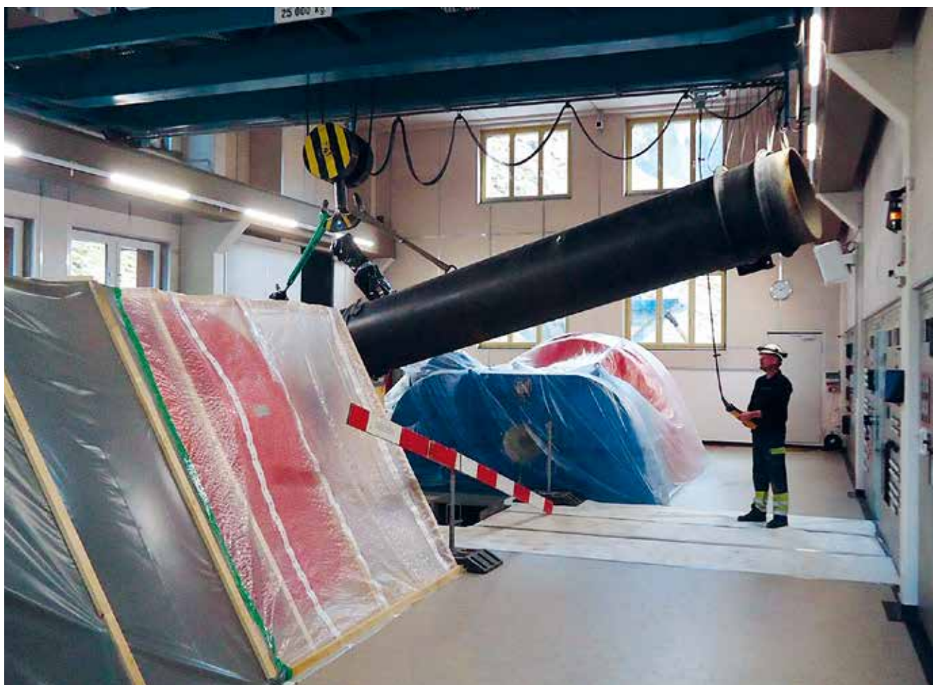
Ruhepause für die Maschinen: Druckleitungserneuerung beim Kraftwerk Glattalp.
