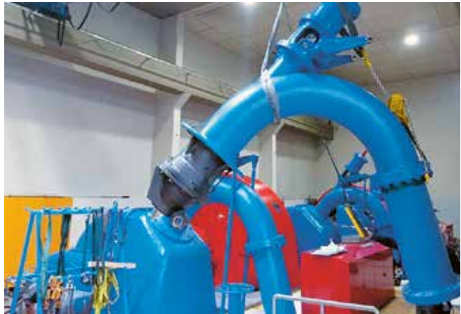
Während der Revision im Kraftwerk Bisisthal werden die Maschinen komplett demontiert.
