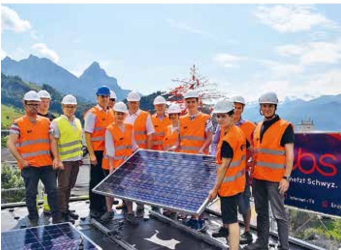
Solarenergie bei ebs: Bau der Photovoltaikanlage auf dem Dach des Schulhauses Halti in Steinen.
